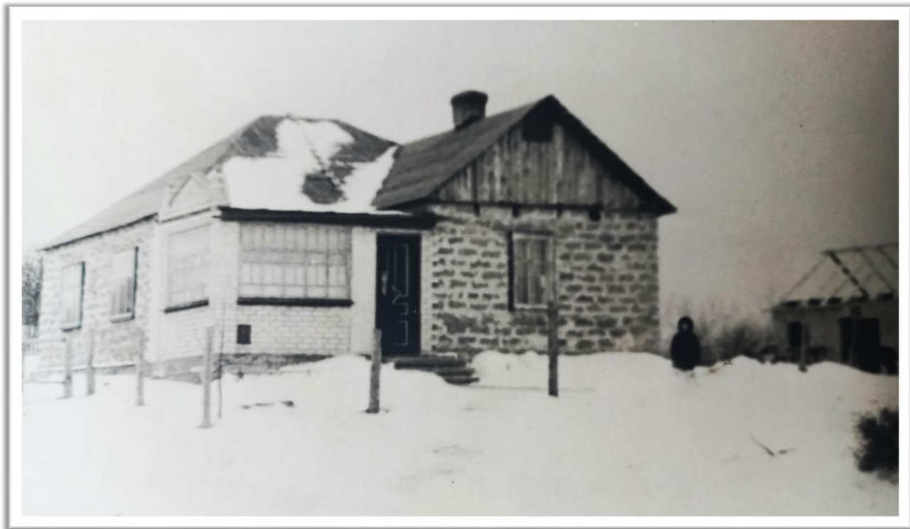
Недобудований будинок в Капитолівці
