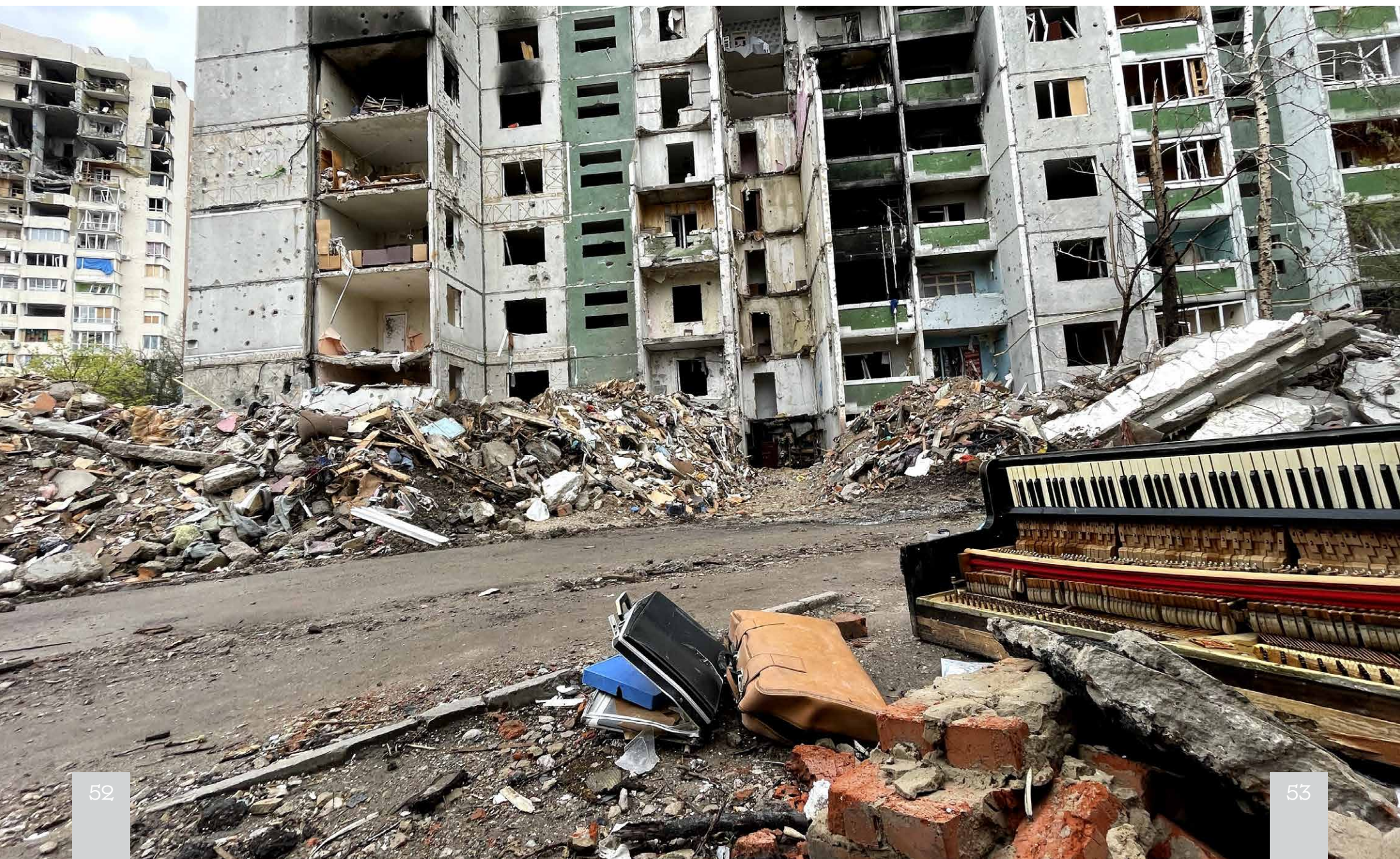
Чернігів. Знищені житлові багатоповерхівки по вул. Чорновола (фото - Юрій Білак)
