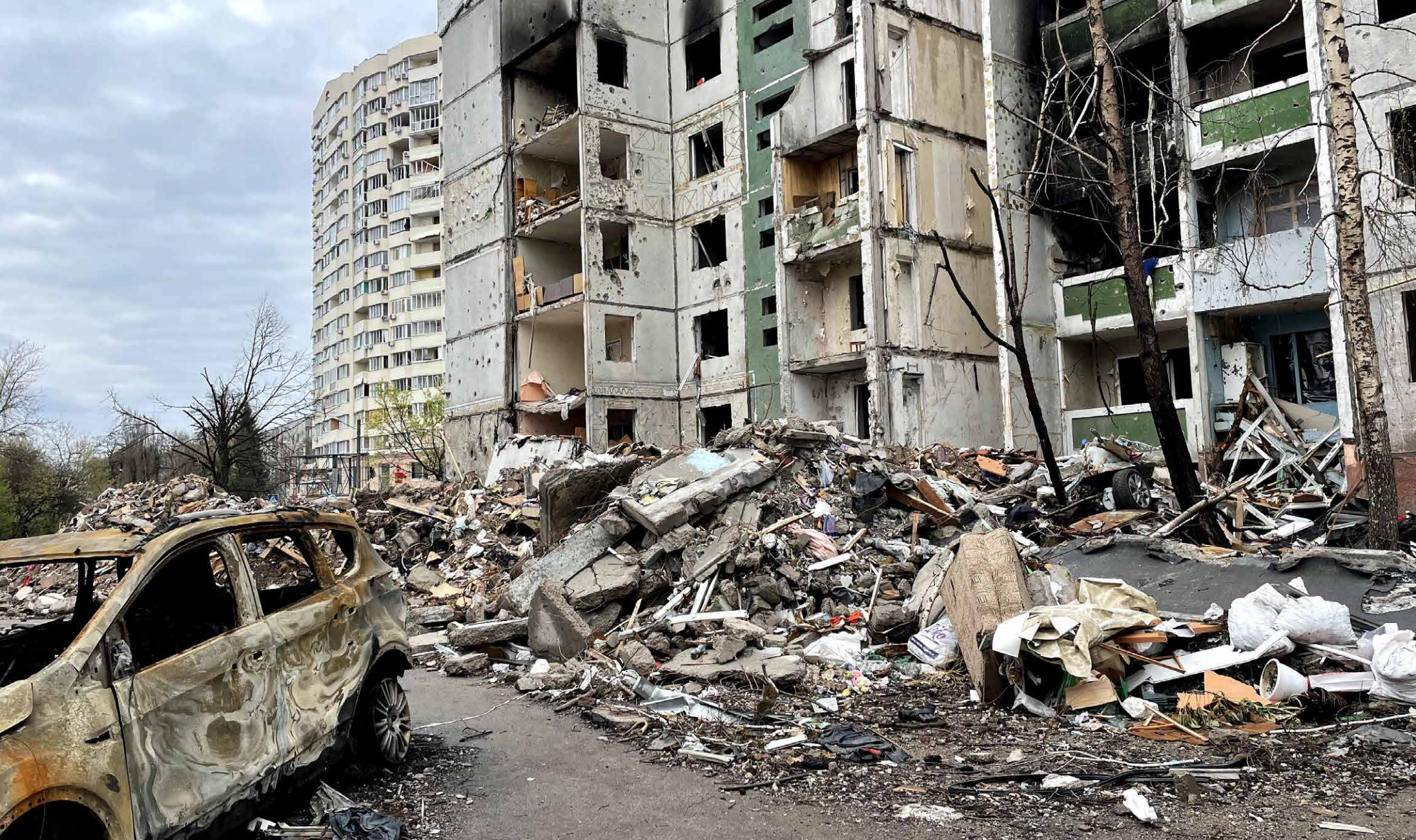
Чернів. Знищені житлові багатоповерхівки по вул. Чорновола (фото – Юрій Білак)
